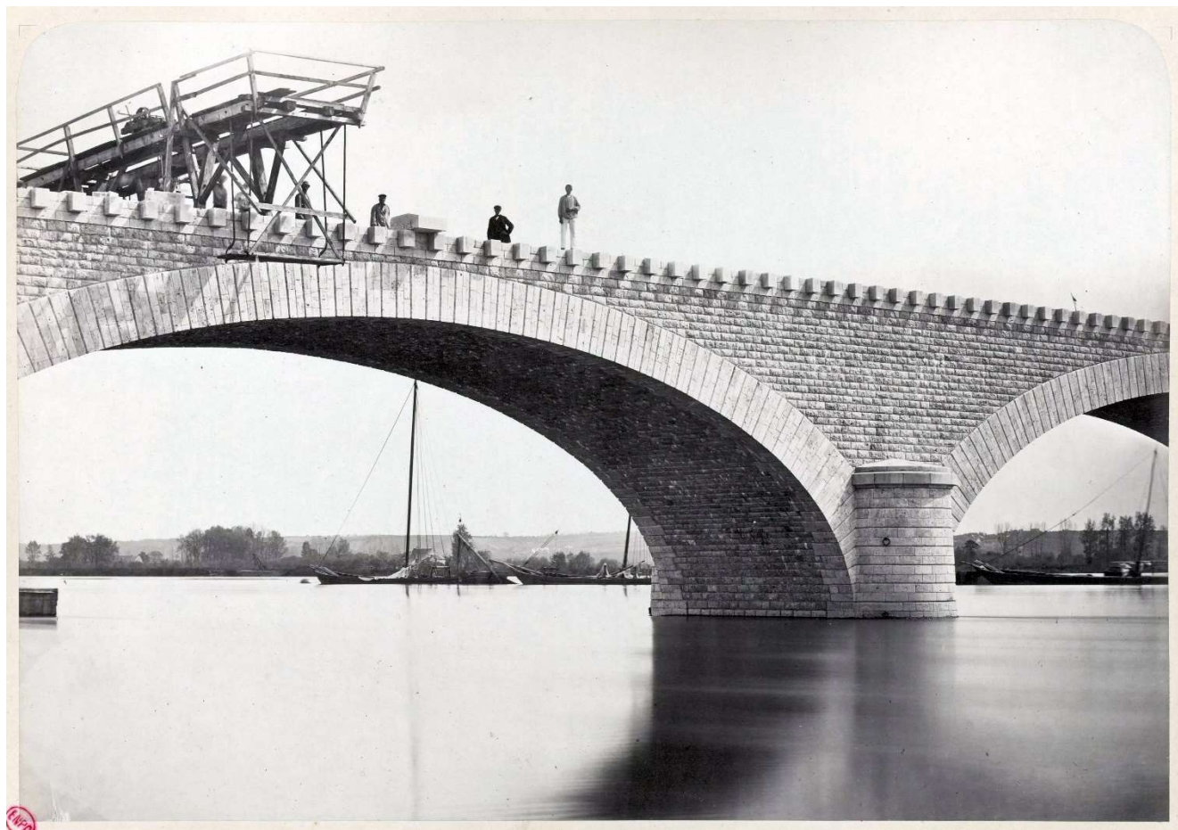
En 1865, le pont est en phase de finition, avant la pose des parapets – BNF
